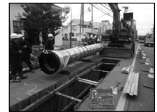
(耐震管の敷設工事)
