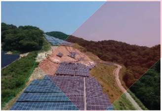
傾斜地の崩壊が発生したため、法肩部分の架台が流出した事例 出典：いずれも、地上設置型太陽光発電システムの設計ガイドライン2019年版（NEDO）
