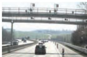
DSRC・レーザセンサ・カメラのある不正防止ガントリー
