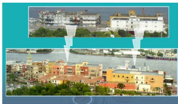
改修前と改修後の全景
