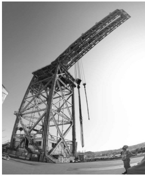
ジャイアント・カンチレバークレーン
